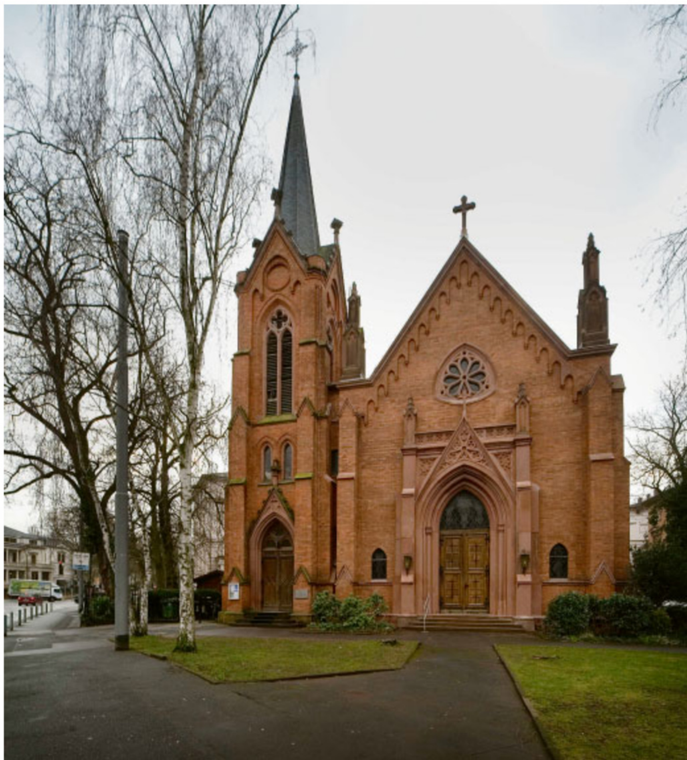
Anfang: Mit der Sanierung des Portals der Englischen Kirche in Wiesbaden haben die Arbeiten zum Umbau begonnen. Foto Kaufhold
